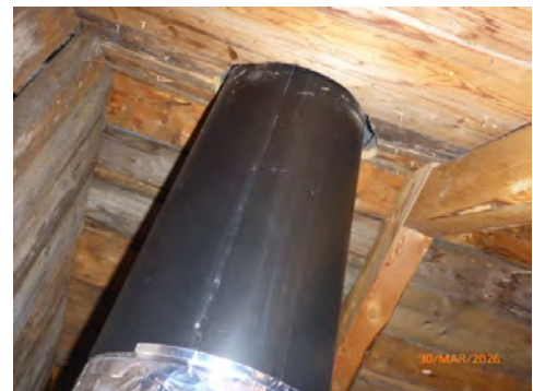
Pipegjennomføring.
