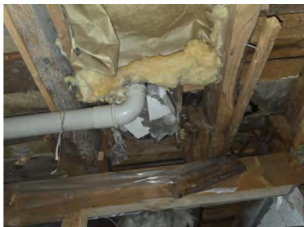
Underside gulv ved sluk
