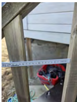
Åpninger mellom spiler på over 10cm
