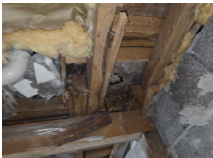
Kobber rør som kommer gjennom badegulv.
