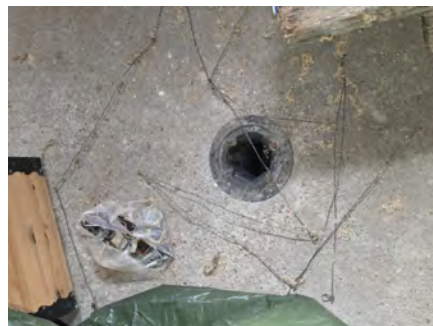
Plast sluk i kjellergulv
