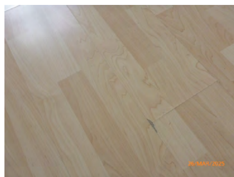
Slitasje laminat på stue
