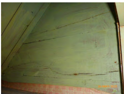
Plank i yttervegger hovedbygget
