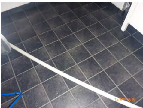
Provisorisk avløp fra vaskemaskin
