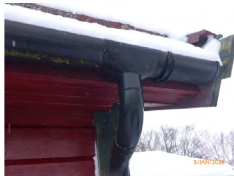
Metallrenne og nedløp
