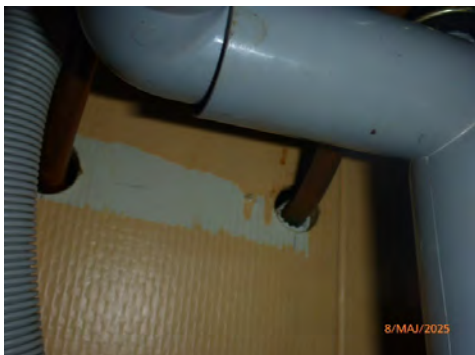
Vannrør i kjøkkenbenk
