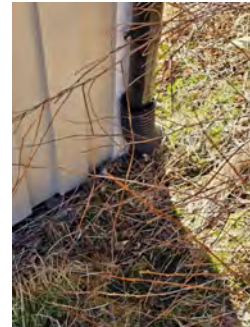
Lav avstand fra bakken til kledning
