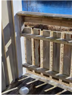
Rekkverkshøyde er målt til 84cm
