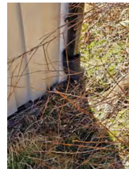
Takrenne er her ført i rør til bakken.
