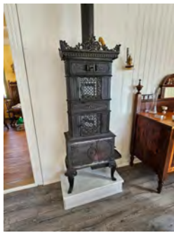
Vedovn i stue med sprekk i godset
