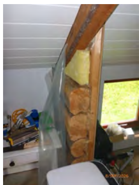
Tømmer med utflyvningshuller
