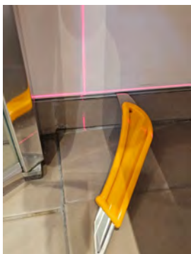
Baderomsplater er ikke fuget utenfor dusj
