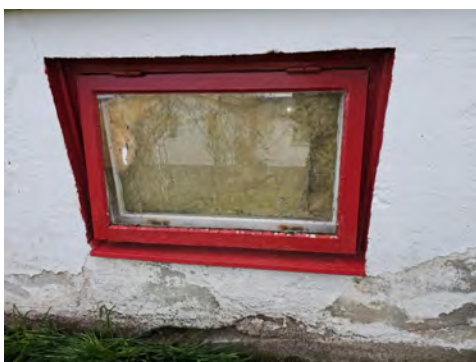
Kjellervindu med skade og koblet glass.
