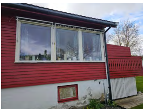
Kjellervindu med skade og koblet glass.
