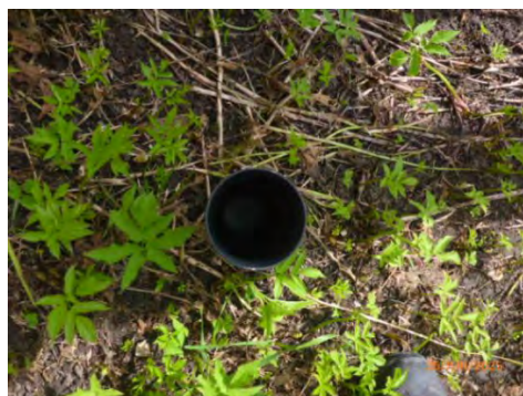
Mulig utvendig stoppekran
