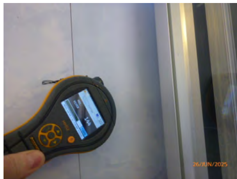
144 våtromsplate oppe på vegg
