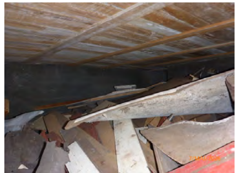
Gulv over krypkjeller nord
