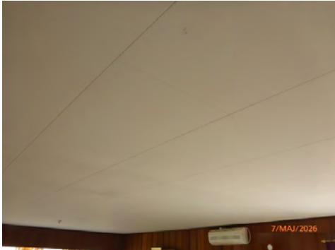
Kaldt loft over tilbygg i nord
