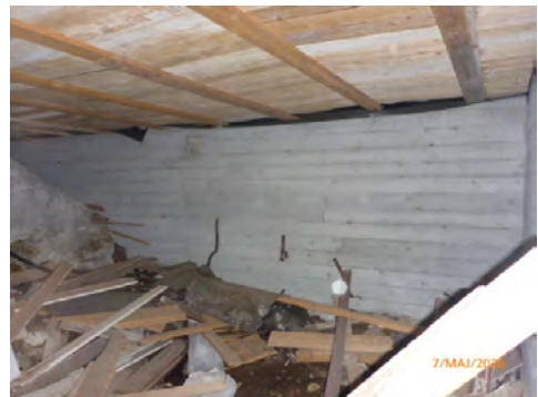
Gulv over krypkjeller nord
