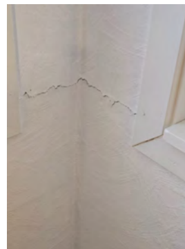
Skader og tørkesprekker i himling
