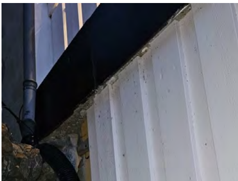
Kledning avsluttet uten lufting mot leca-plank
