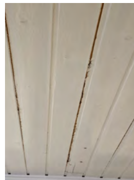
Skader og tørkesprekker i himling
