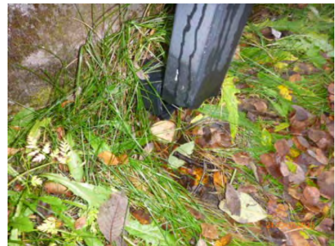
Skader taknedløp
