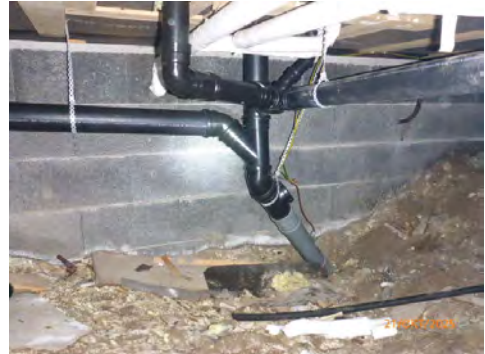
Avløpsrør i krypkjeller
