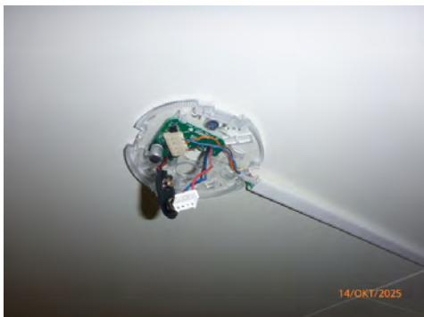
Skade på røykvarsler gang i underetasjen.
