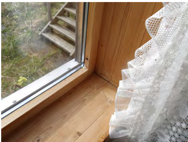
Vinduer fra 1990 på en av veggene.
