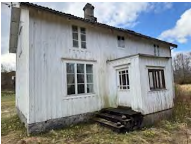
Koblede trevinduer og vinduer av tre med enkle glass.
