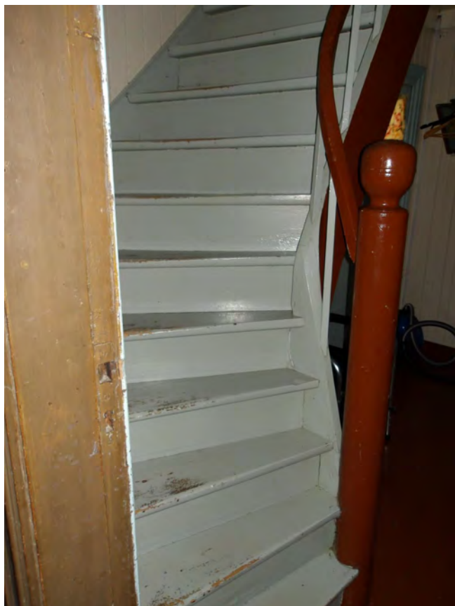
Tretrapp opp til 2. etasje.
