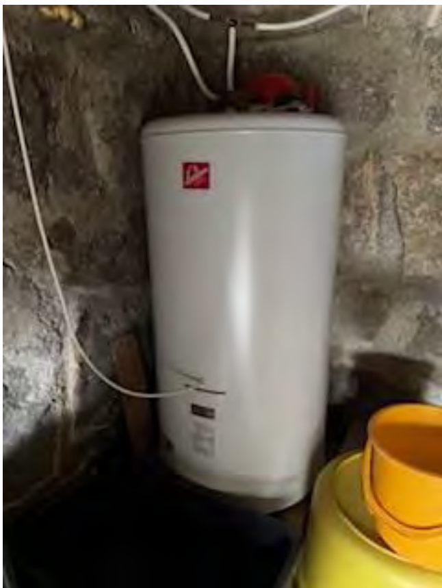
Varmtvannstank
