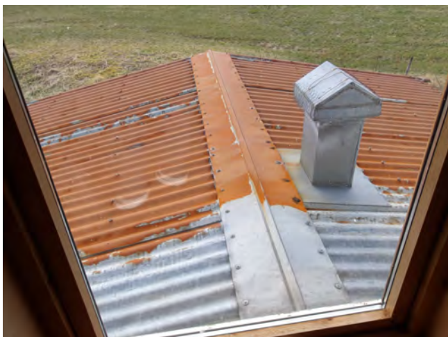
Taktekke på tilbygget
