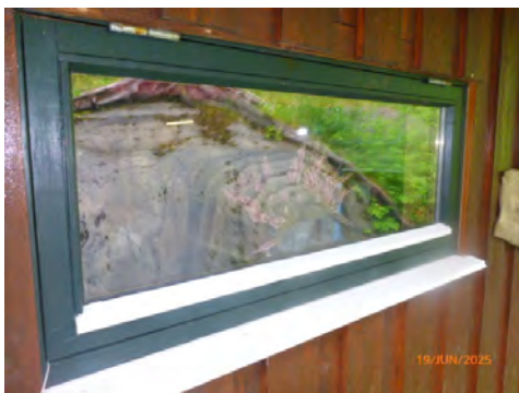
Vinduer fra rundt byggeår.
