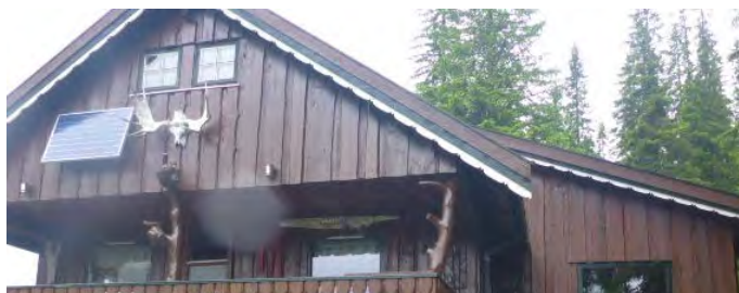
Vegg mot sørøst, opprinnelig og tilbygg
