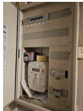
Ledninger ikke festet og ikke tilkoblet til kontakt
