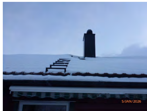
Takstige og pipebeslag
