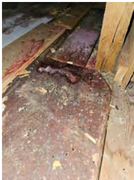
Fuktsjolder ved pipe, tørrt ved befaring
