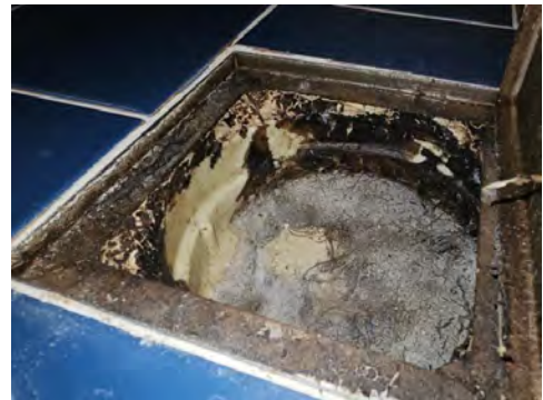
Sluk, ikke observert membran/tetting i sluk
