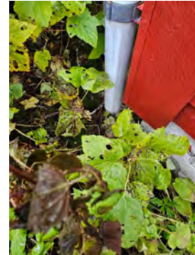
Taknedløp er avsluttet ved bakkenivå
