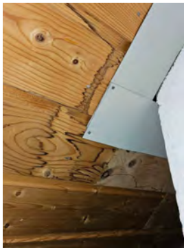
Fuktsjolder ved pipe, tørrt ved befaring
