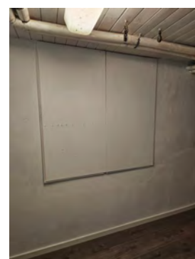
Mulig luke til krypkjeller under stue
