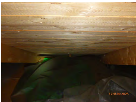
Fuktmerker, tørt ved befarings
